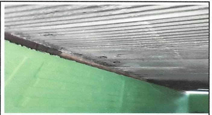
Foto 8: La estructura del soporte de madera esta en malas condiciones debido al deterioro de la misma
