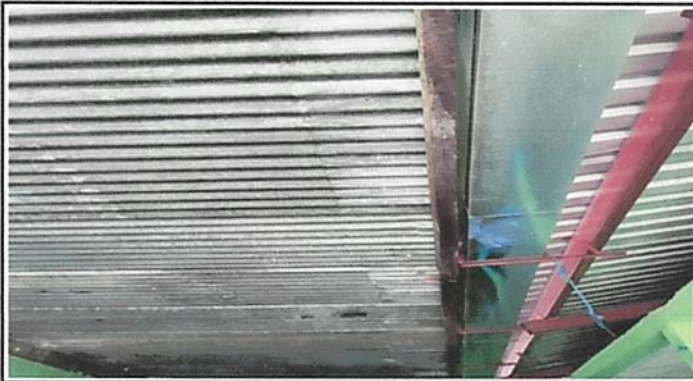
Foto 7: La lámina esta en malas condiciones debido al deterioro y oxidación.
